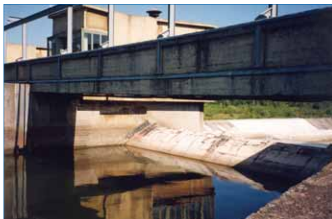
Jedno z trzech przesł jazu kłapowego zapory w Czańcu – przepustowość jazu przekracza 1000 m 3 /s
